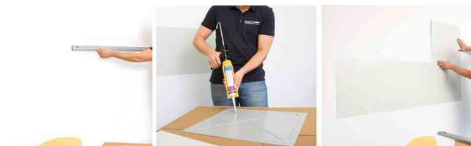
Wandfläche ausmessen - Platten mit Kleber versehen - die magnetowand® entsteht
